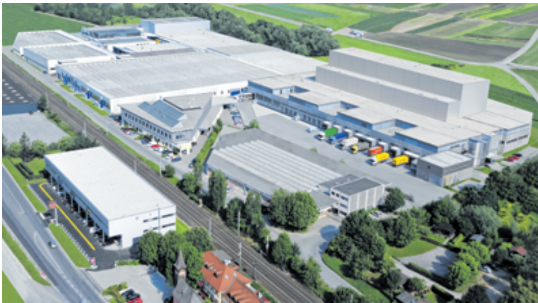
In der Werkszentrale in Hall erfolgt die weltweite Entwicklung und Produktion der Holzbearbeitungsmaschinen.
